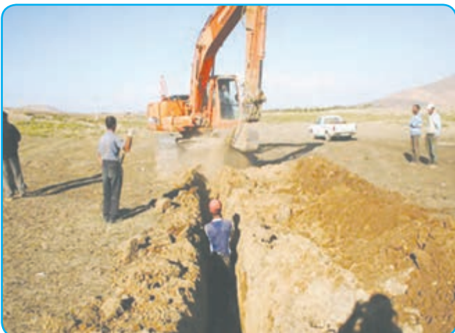
کندن زمین با بیل مکانیکی
