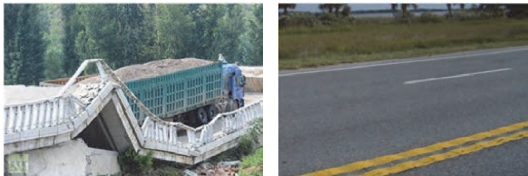
شکل ۱۳- تخریب رویه روسازی و ابنیه فنی
