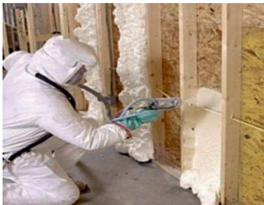
عایق‌بندی با نوعی فوم خمیری
