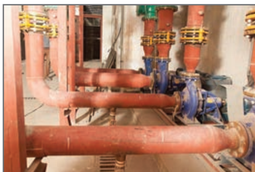
شکل ۳۳- خط مکش پمپ زمینی
