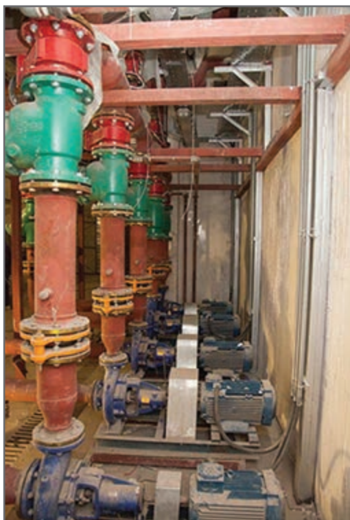
شکل ۳۲ - خط رانش پمپ زمینی
