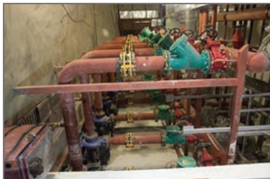
شکل ۳۳- خط مکش پمپ زمینی
