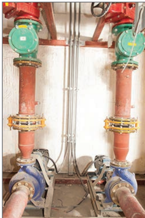
شکل ۳۲ - خط رانش پمپ زمینی
