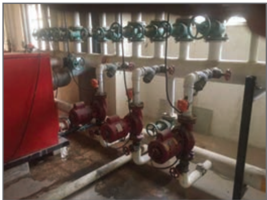
شکل ۱ - پمپ سیرکولاتور سیستم گرمایی
