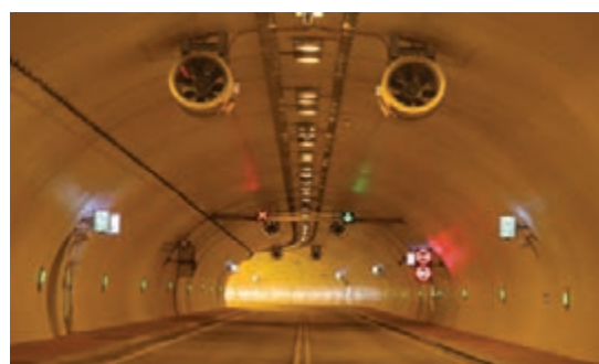
شکل ۱۸- تهویه‌های هوای نصب شده در تونل
