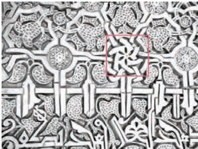
شکل ۳۳-۶. بخشی از گجبری مسجدی در ارومیه
