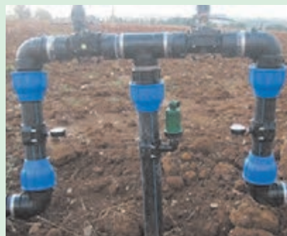
شکل ۳۲-۵. شیر و فشار سنج روی بال ها
