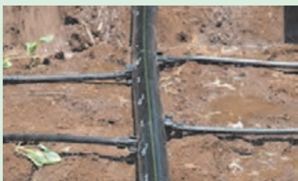
شکل ۱۸-۵. ردیف نوارهای روی لوله
