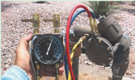
شکل ۳۱-۵. تنظیم فشار شیر فشار شکن
