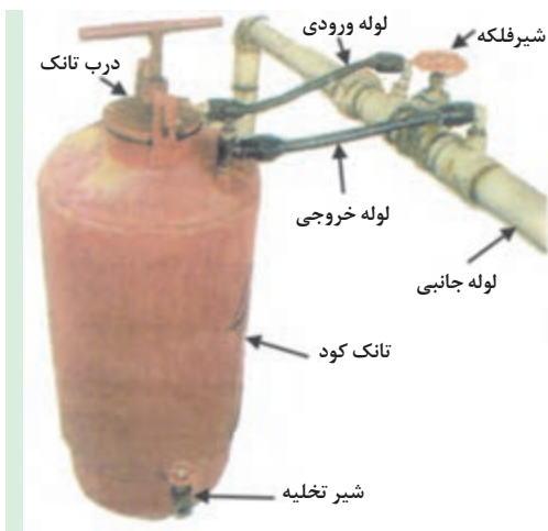
شکل ۴۹-۵. اجزای سیستم توزیع کود
