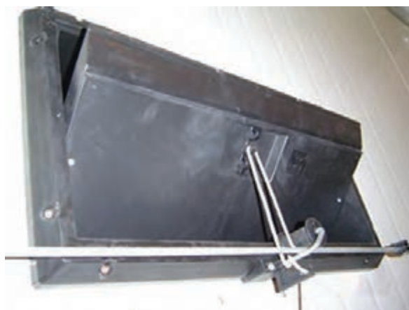
دریچه‌های ورودی هوا (اینلت)
