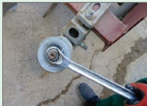
شکل ۴۵- آچارکشی نقاط اتصال اجزا و قطعات
