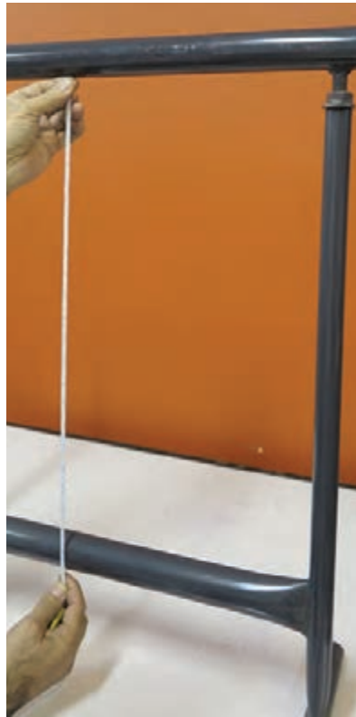
تصویر ۱-۷ ▲ اندازه گیری فاصله داخلی و میانی دار
