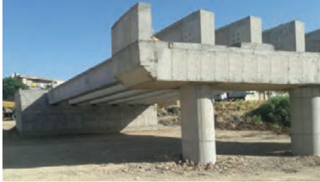
شکل ۱۲- تصویر پل نیمه تمام
