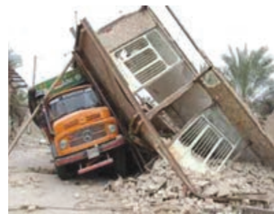
الف) ریزش دیوار در اثر زلزله
