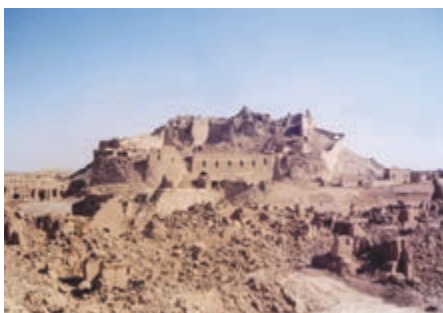
ج) ارگ بم بعد از زلزله
