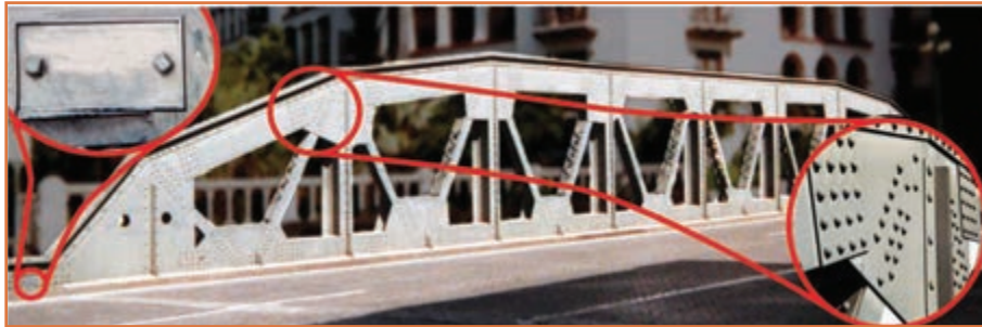
شکل ۳- اتصال دائم : پرچ
