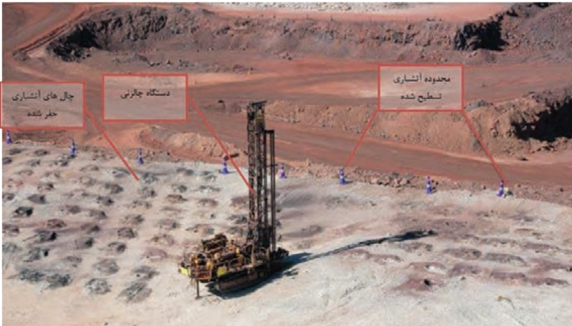
دستگاه حفاری DTH در حال حفر چال‌های انفجاری
