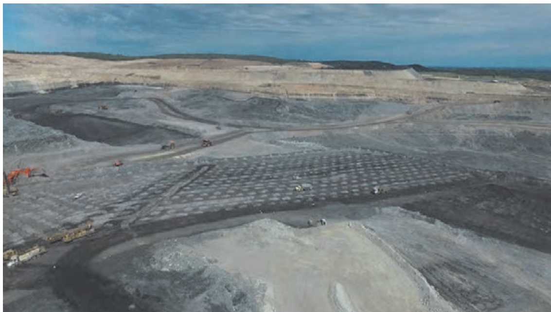
شبکه چال آتشیاری حفر شده
