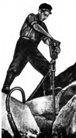
شکل ۴-۱۳- وضعیت ناپایدار کارگر کوه‌بُر بر روی گرانیت (۶)
