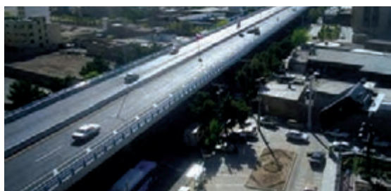
پل روگذر آزادراه از جنس فولاد آلیاژی
