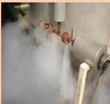
نشتی از اتصال در خط لوله
