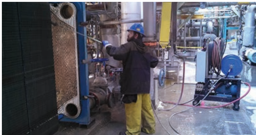
شکل ۱۵- روش فشار آب (جت آب)
