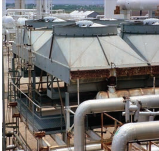
شکل ۳۳- انواع خنک‌کننده هوایی
