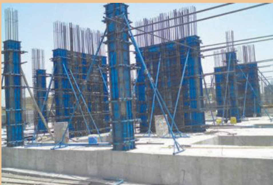
قالب‌بندی و آرماتوربندی ستون
