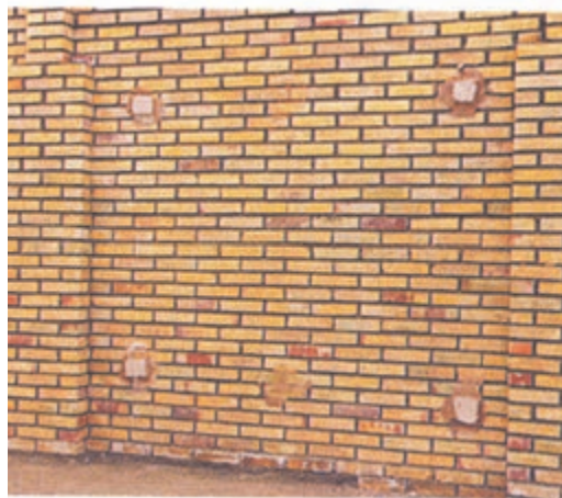
▲ شکل ۲۱ کرم‌بندی ابتدا و انتهای دیوار
