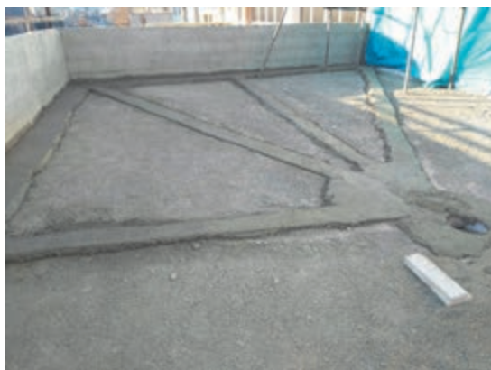
شکل ۱۴ ▲ کرم‌بندی و شمشه‌گیری بین آن‌ها
