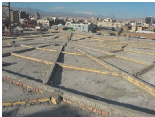
شکل ۱۴ ▲ کرم‌بندی و شمشه‌گیری بین آن‌ها
