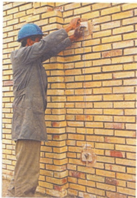
▲ شکل ۲۰ شاقولی کردن کرم‌ها
