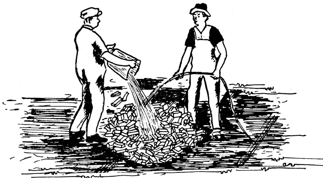
شکل ۳۷ ▲ زنجاب کردن آجر
