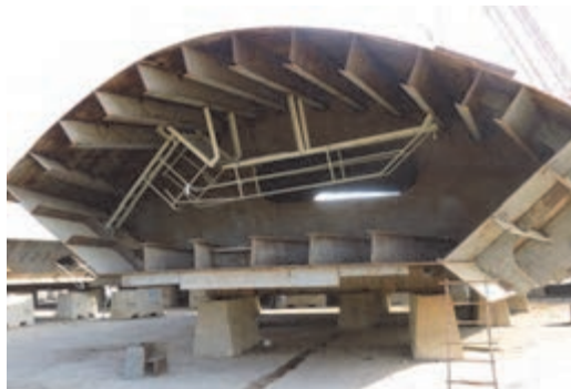
شکل ۶- اتمام جوش کاری بلوک کشتی
