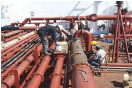
شکل ۷- در حال اجرای لوله‌کشی کشتی
