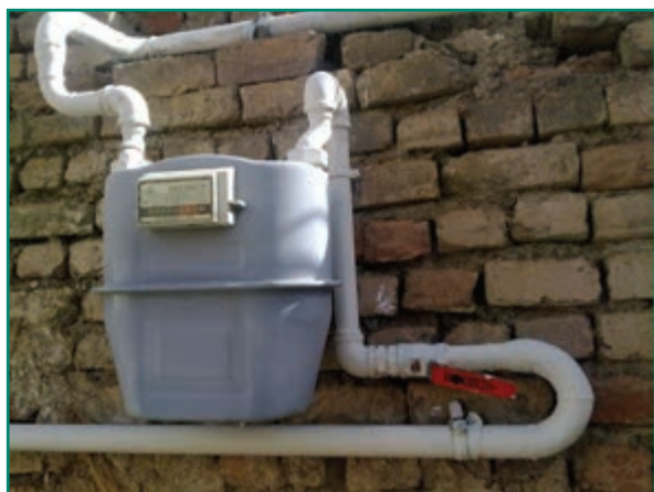
شکل ۸۱-۴ یک کنتور ۱۰ متری نصب شده
