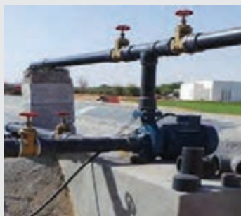
شکل ۱۸- شیرفلکه لوله رانش
