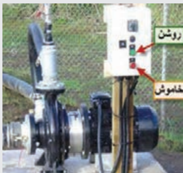
شکل ۲۰- کلیدهای کنترل روی تابلو
