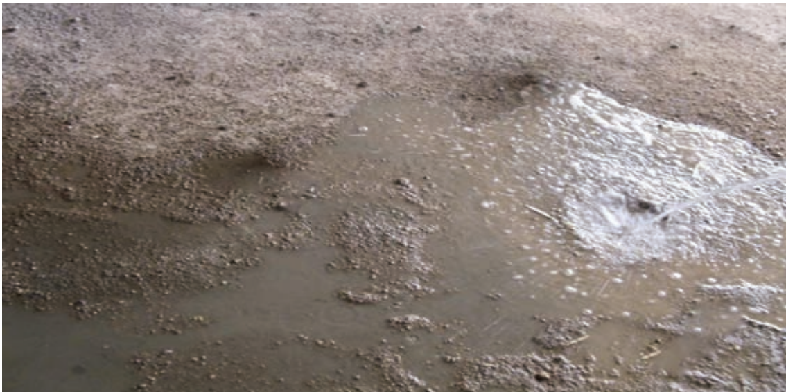
شکل ۱- ۶۷: خیس کردن سطح زیر کار
