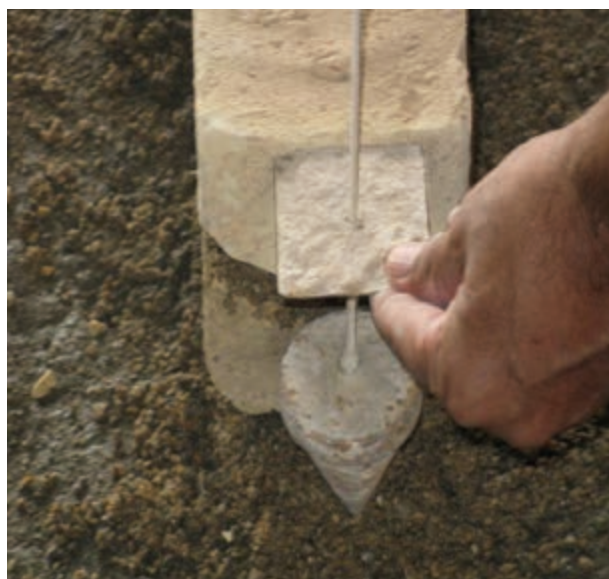
شکل ۱ - ۹۴: شاقول کردن نبش کار
