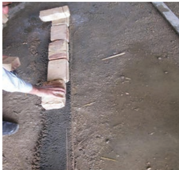
شکل ۱ - ۹۱: نحوه چیدن آجر در امتداد ریسمان کار
