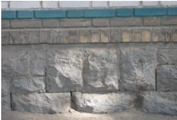
شکل ۱ - ۱۵ : کاربرد سنگ در پایه های ساختمان
