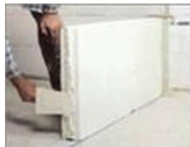
شکل ۱- ۳۶: طریقه نصب بلوک های گچی
