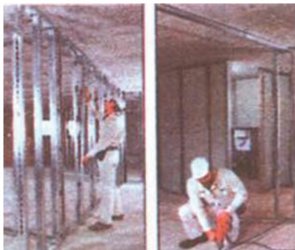
شکل ۱-۴۴: قاب سازی جهت اتصال روکش های گچی
