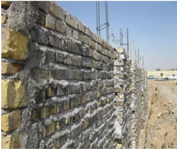
شکل ۱ - ۲۶: دیوار آجری با کلاف بندی قائم
