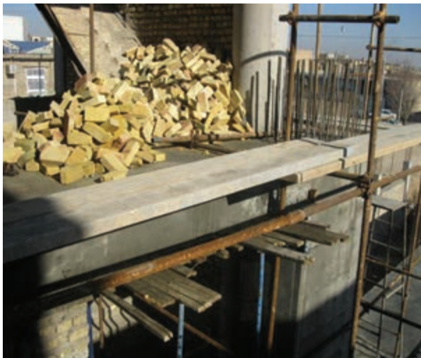
شکل ۱-۲: ضخامت مناسب برای تخته زیر پایی
