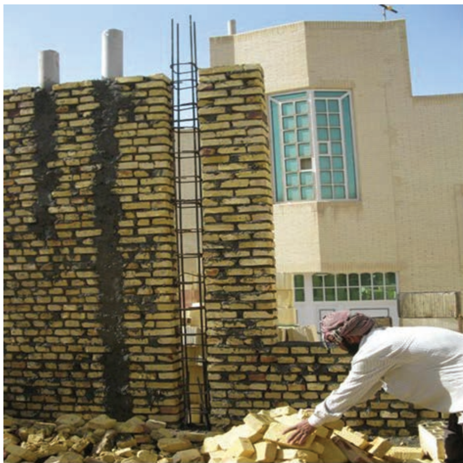
شکل ۱ - ۶۰: اتصال کلاف قائم و افقی در دیوار
