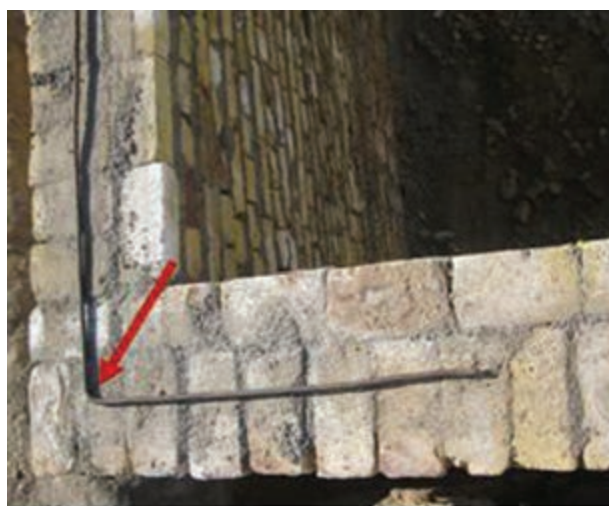
شکل ۱ - ۵۵: میلگرد گذاری در محل اتصال دو دیوار
