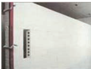
شکل ۱- ۳۷: دیوار جداکننده با قطعات پیش ساخته گچی
