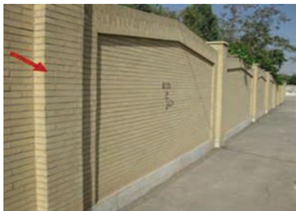
شکل ۱ - ۵۸: وابند در دیوار حصارکشی
