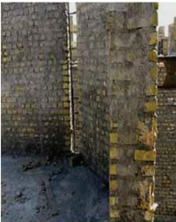
شکل ۱- ۵: دیوار باربر
