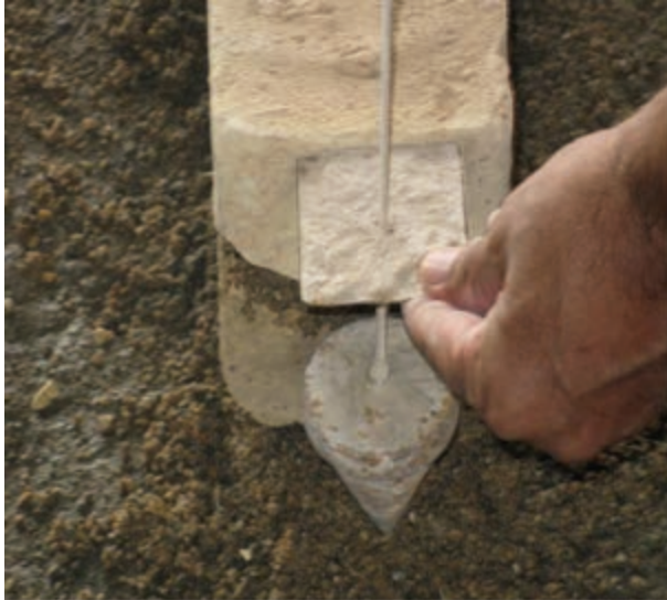
شکل ۱- ۷۷: شاقول کردن نبش کار
