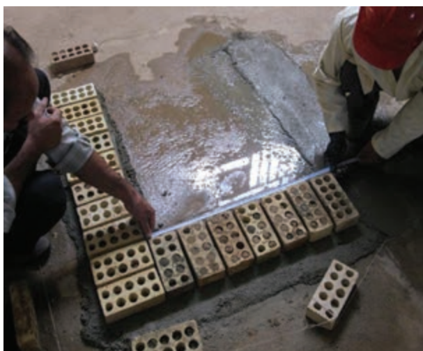
شکل ۱ - ۳۳ (الف): برداشتن طول دیوار
