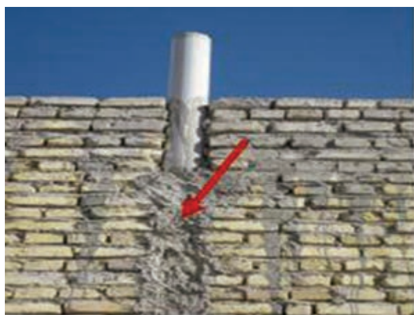
شکل ۱ - ۶۵: پر کردن درز لوله‌ها
