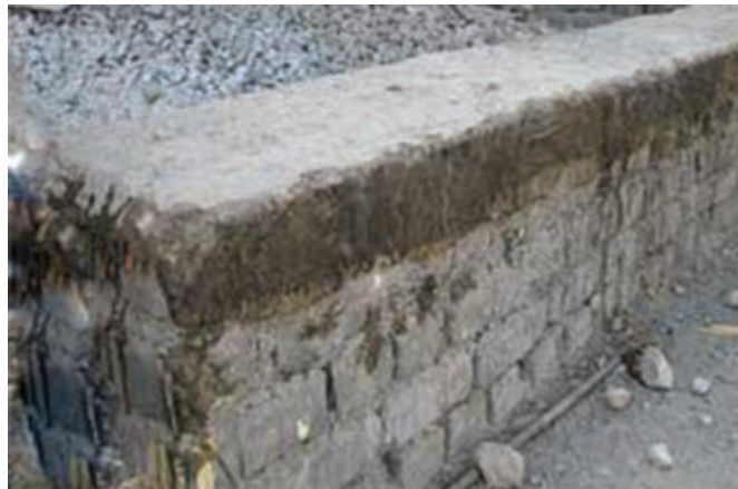
شکل ۱- ۲۹ : کرسی چینی یا عایق کاری رطوبتی
