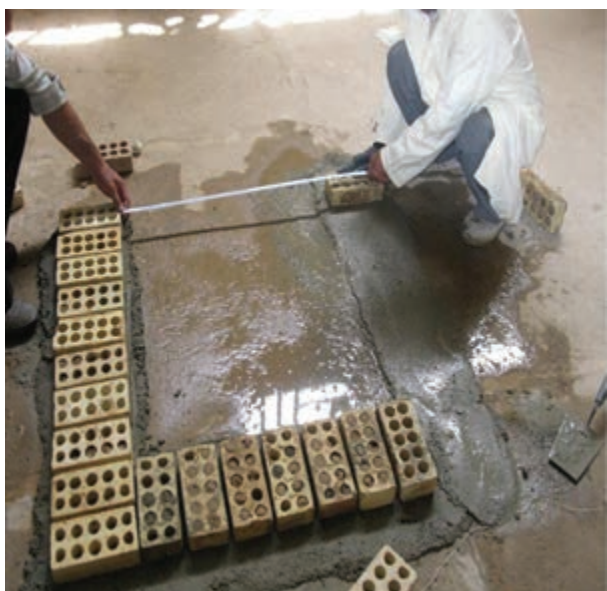
شکل ۱ - ۳۳ (ب): جدا کردن اندازه دو طرف دیگر
