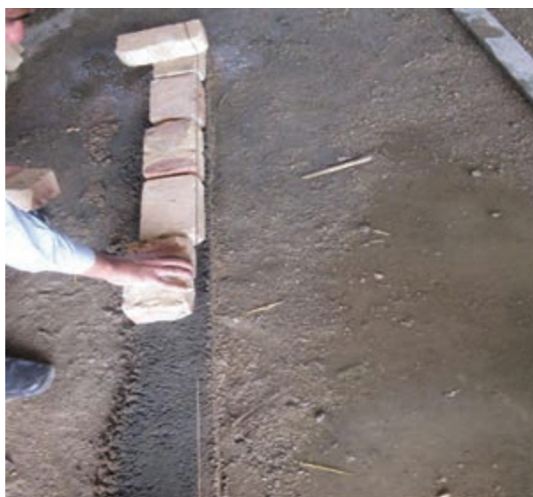
شکل ۱- ۷۴: نحوه چیدن آجر در امتداد ریسمان کار
