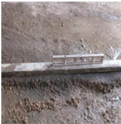
شکل ۱- ۱۰۵: تراز کردن روی ملات
