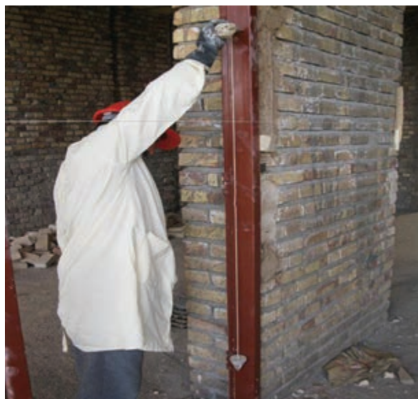
شکل ۳-۲۳: شاقول کردن وادار
