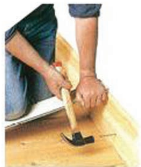
شکل ۳- ۲۹: نصب قرنیز چوبی با میخ
