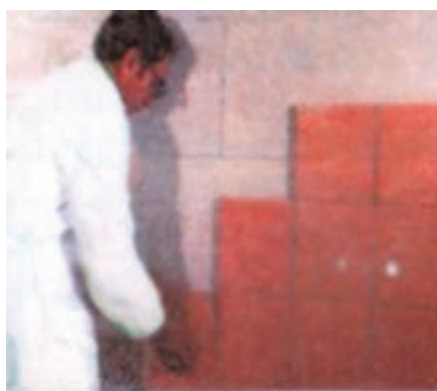
شکل ۱ - ۴۳: نصب کاشی روی قطعات پیش ساخته گچی
