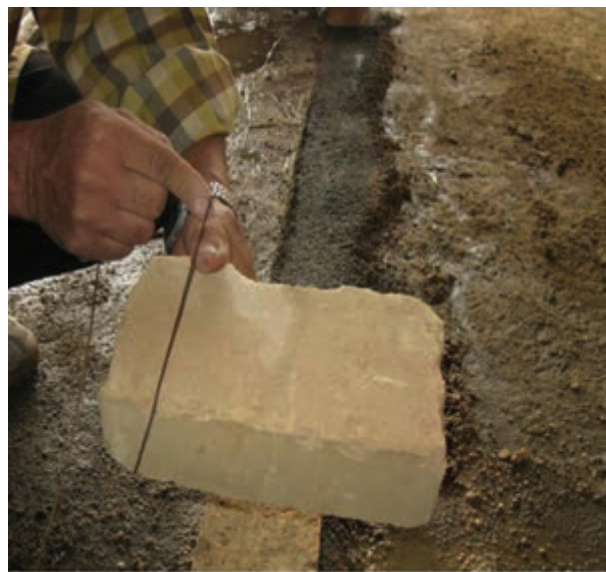
شکل ۱- ۸۹: نحوه بستن ریسمان کار به آجر
