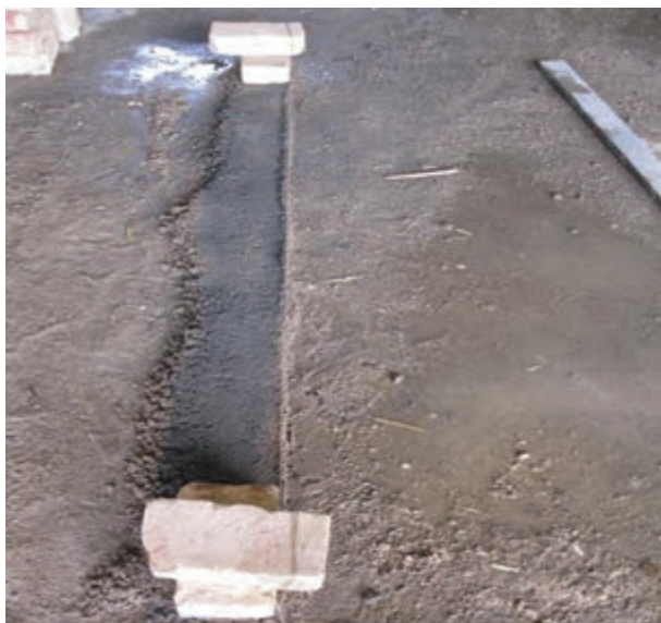
شکل ۱- ۹۰: بادخور نمودن ریسمان کار
