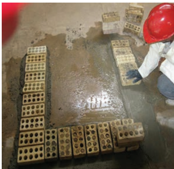
شکل ۱ - ۳۳ (ج): ریسمان کشی و چیدن ضلع سوم
