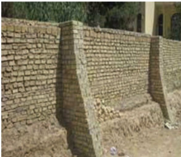
شکل ۱-۷: دیوار باربر
