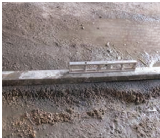
شکل ۱- ۶۹: تراز کردن روی ملات
