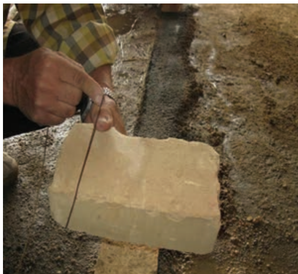
شکل ۱- ۷۲: نحوه بستن ریسمان کار به آجر
