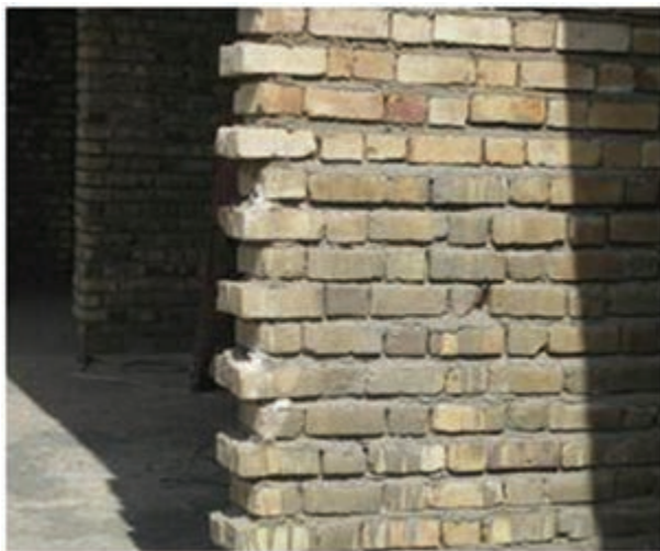
شکل ۱-۵۲: لابند در دیوار آجری
