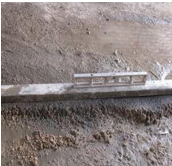
شکل ۱ - ۸۶: کنترل تراز سطح ملات
