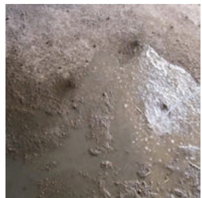
شکل ۱- ۱۰۳: خیس کردن سطح زیر کار
