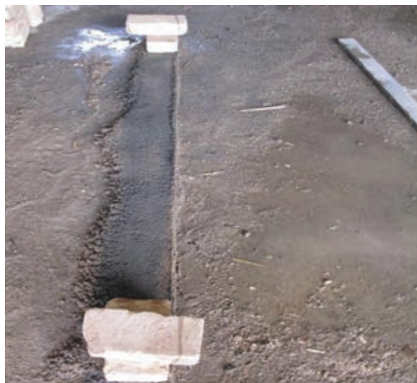
شکل ۱- ۷۳: بادخور نمودن ریسمان کار
