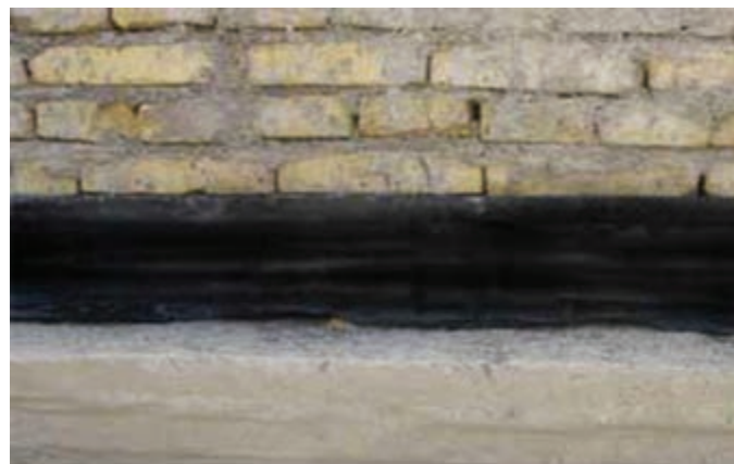
شکل ۱- ۳۰ : دیوار روی کرسی چینی
