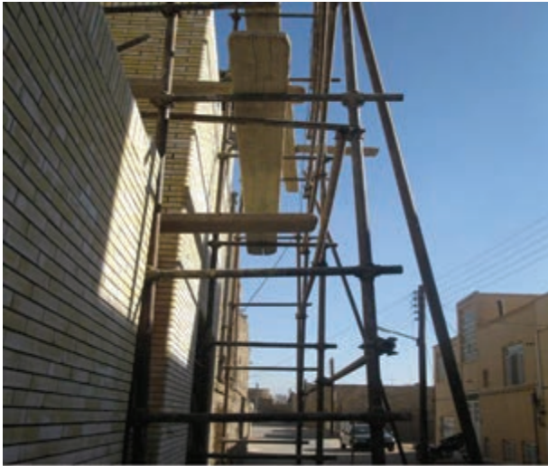
شکل ۱-۱: داربست فلزی برای چیدن دیوار
