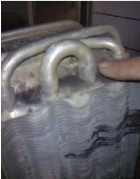
شکل ۱۱- تشکیل رسوب در آب گرم‌کن
