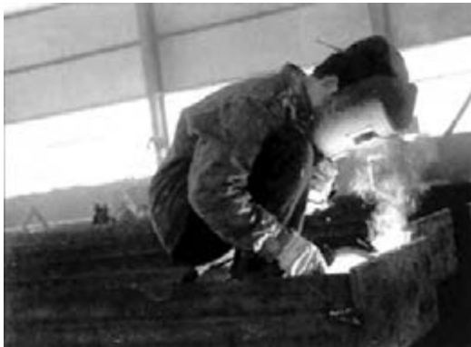
شکل ۲- جوشکاری با الکترودهای روکش دار
