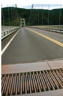
(ب) نمونه‌ای از بست‌های انبساطی
