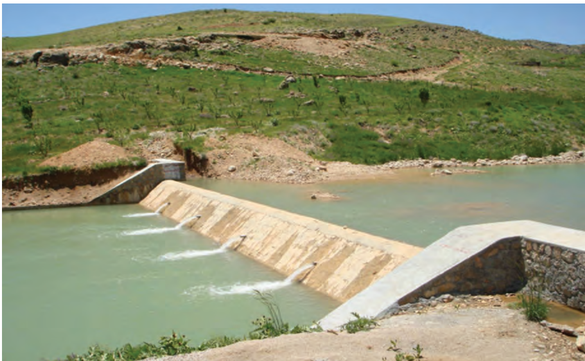
شکل ۲۶-۱- پروژه آبخیزداری بندسنگی ملاتی سرچنار
