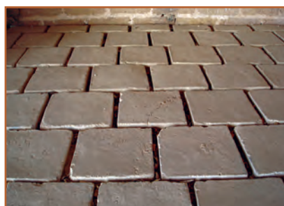
ب - استفاده از آجر برای کف
