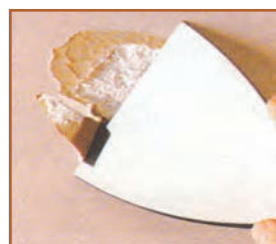
الف - باز کردن ترک‌ها
