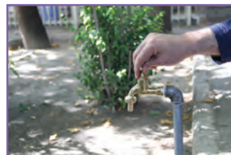
خ - آزمایش آب بندی شیر
