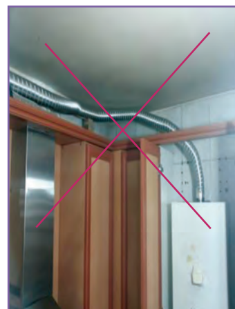
ح - هرگز از لوله های خرطومی به جای لوله رابط دودکش استفاده نکنید.
