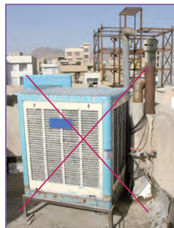
ب - فاصله بین دودکش تا کولر آبی و یا پ - فاصله بین دودکش تا کولر آبی و یا دریاچه های تأمین هوای ساختمان دست کم سه متر باشد.
