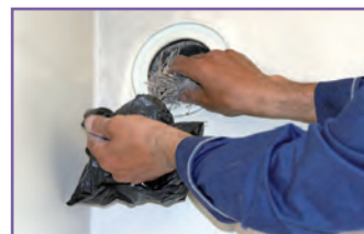
پ - برای خروجی دودکش هر دستگاه گاز سوز یک کلاhek H نصب شود.
