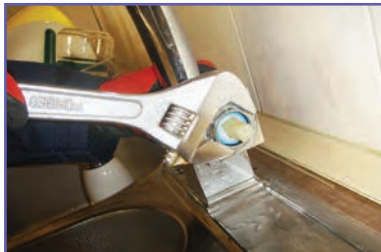
ث- باز کردن پیچ روی مغزی (گلند)
