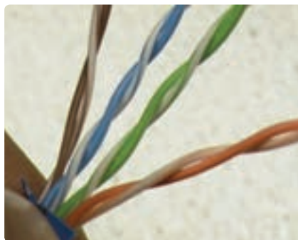
شکل ۴۴-۴- روکش‌برداری از کابل شبکه
