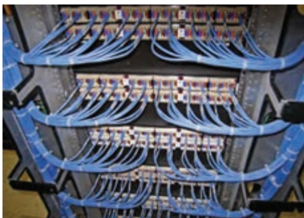
شکل ۲۸-۴- کابل کشی پشت پانل Loaded Patch Panel
