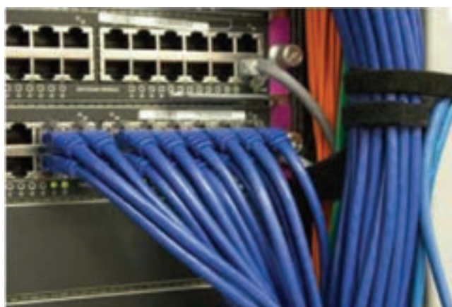
شکل ۲۵-۴- اتصال کابل‌ها به پیچ پانل
