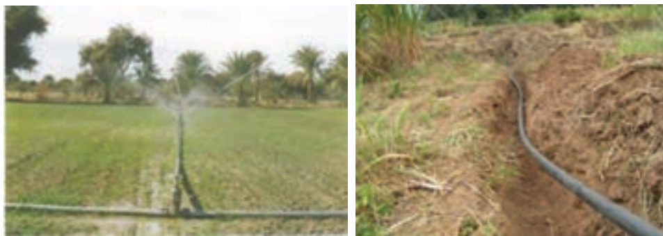
الف) لوله‌های نیمه اصلی داخل کانال حفر شده (ب) لوله‌های نیمه اصلی روی زمین
