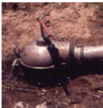
ب) شیر هیدرانت سر لوله زیر زمینی
