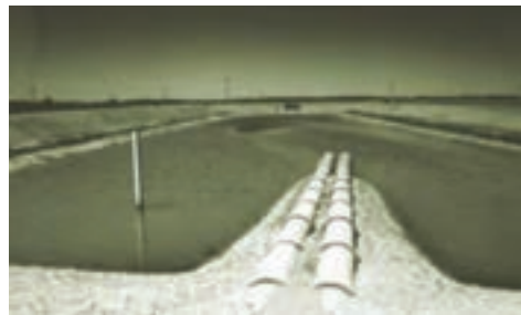
الف) استخر ذخیره آب و لوله‌های آبیاری
