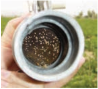
شکل ۱۸-۷- صافی (فیلتر) در مسیر لوله نیمه اصلی
