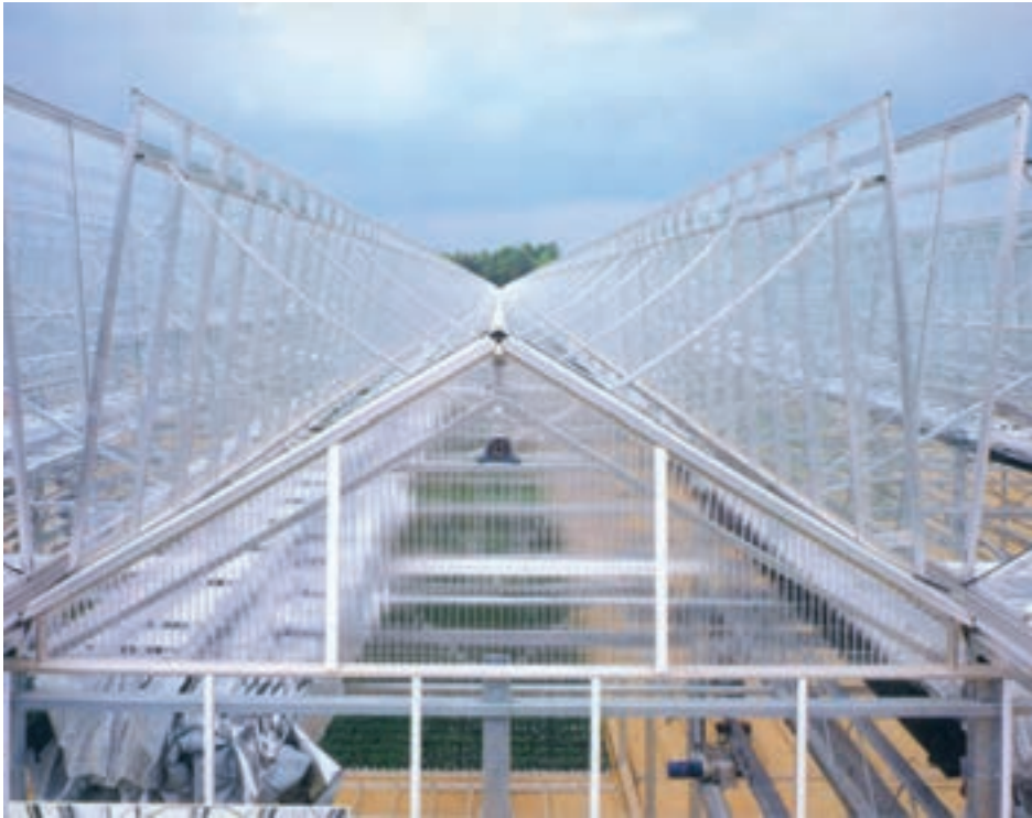
شکل ۱۷-۶- نمونه سقف یک گلخانه که به وسیله‌ی کامپیوتری باز و بسته می‌شود.
