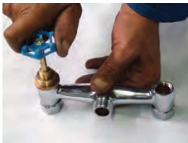
ج) عمل کف تراشی شیر
