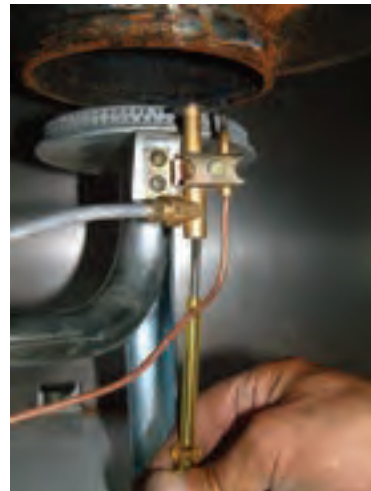
شکل ۶-۱ تنظیم شعله پیلوت
