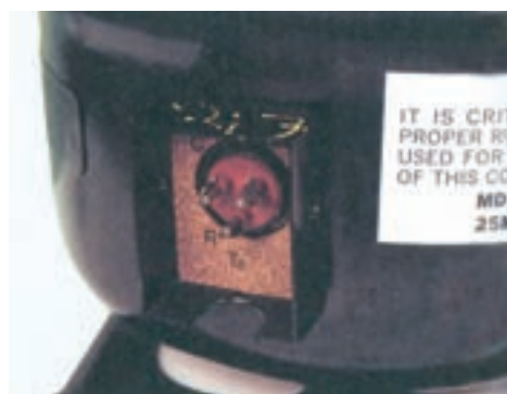
د) جعبه ترمینال موتور کمپرسور
