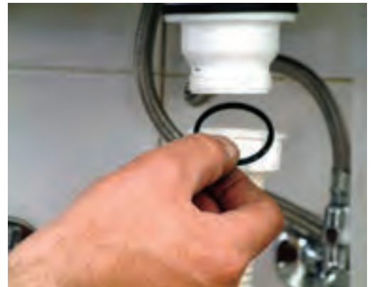
۴- قرار دادن واشر لاستیکی در درون مهره سیفون عمودی
