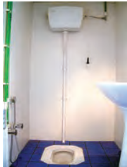
شکل ۳۳-۱۰- اتصال مخزن فشاری به کاسه توالت ایرانی
