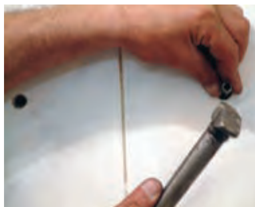
۳- کوبیدن رول پلاک در درون سوراخ‌ها
