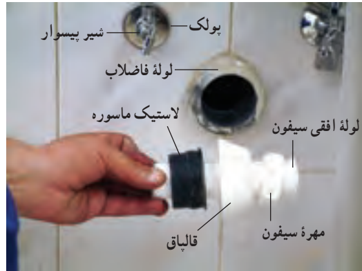
۲- عبور دادن لوله سیفون افقی از درون مهره سیفون، قالیاق و لاستیک ماسوره
