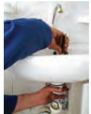
۱- بستن زیراب دست شویی به وسیله پیچ گونشتی
