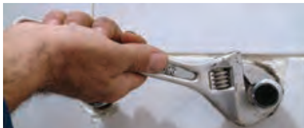
۵- سفت کردن دنباله‌ها با آچار فرانسه
