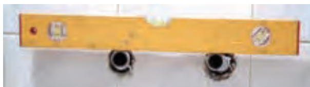
۷- سنجش صاف بودن دنباله‌ها به وسیله تراز
