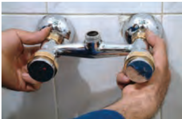
۱۰- بستن مهره‌های تنه شیر مخلوط به دنده \frac{3}{4} " دنباله‌ها به وسیله هر دو دست
