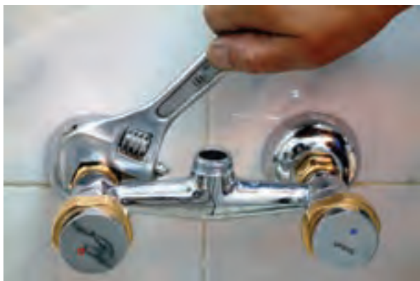
۱۱- سفت کردن مهره‌های شیر مخلوط دیواری با آچار فرانسه
