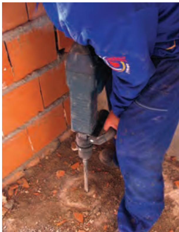
شکل ۴-۸ - سوراخ‌کاری برای عبور لوله فاضلاب
