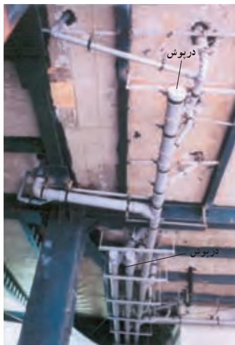
شکل ۵-۸ - بستن دهانه‌های باز بلافاصله پس از لوله کشی
