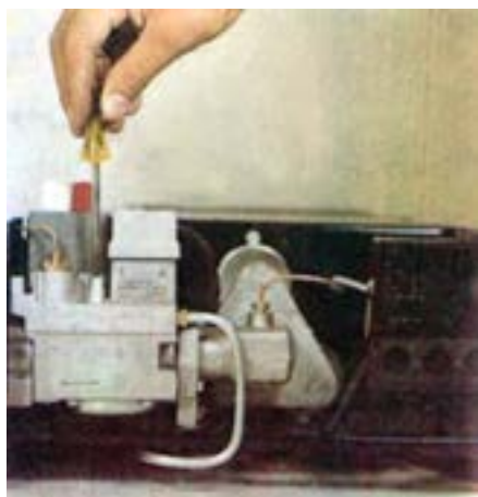
شکل ۳۲-۵ - تنظیم شعله پیلوت
