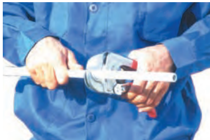
شکل ۲-۴- بریدن لوله با قیچی
