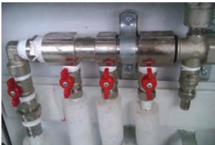
شکل ۱۹-۳- اتصال سرلوله‌ها به کلکتور
