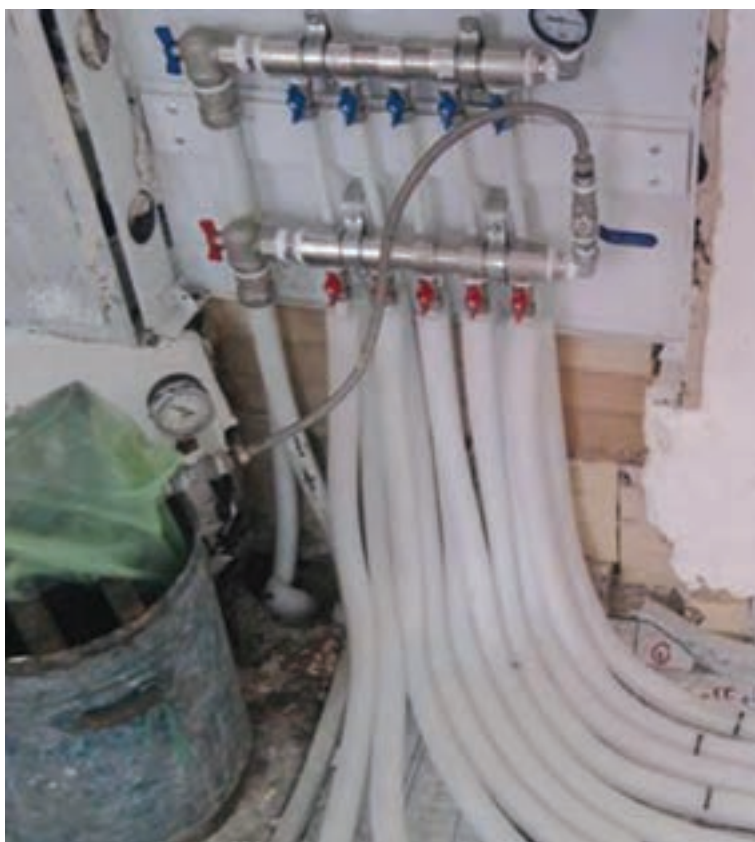
شکل ۲۰-۳- آزمایش آب‌بندی لوله‌کشی
