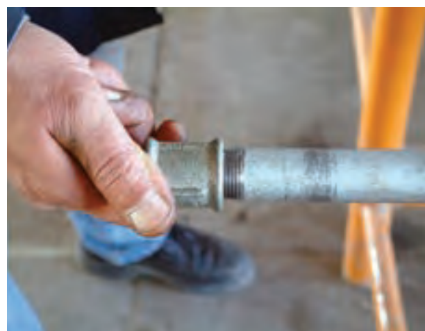
شکل ۱-۳۶ - آزمایش دنده
