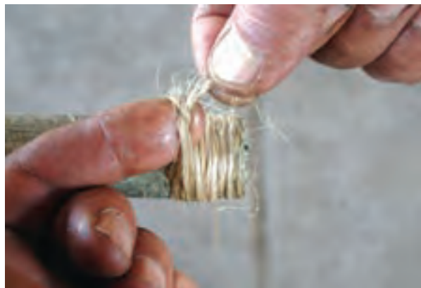
ب) کنف پیچی سر دنده (گره زدن)
