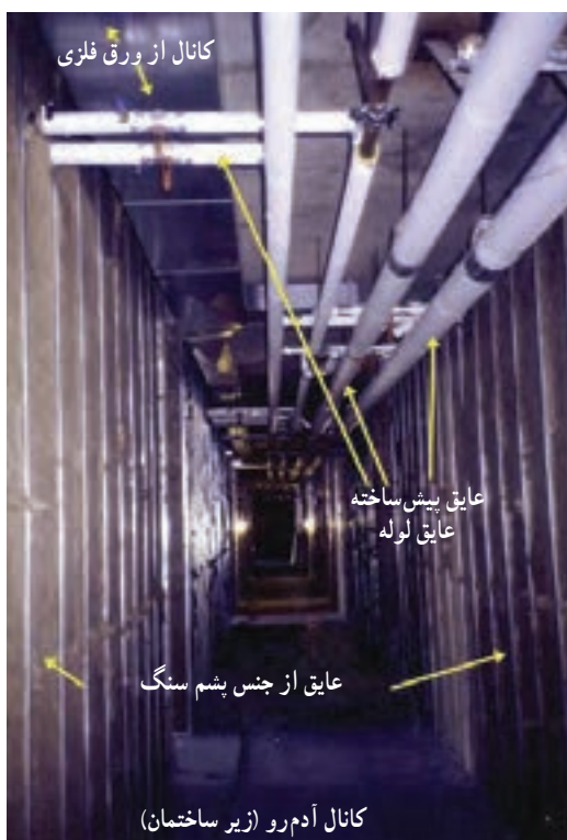
شکل ۲۲-۲- عایق کاری
