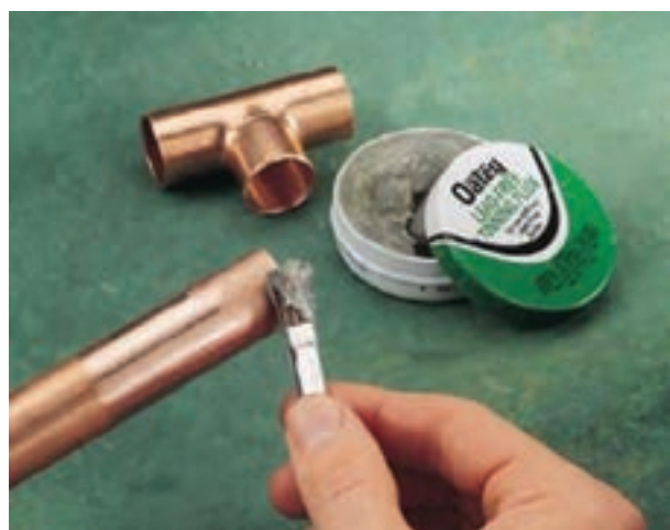
شکل ۱-۴۲- مراحل اتصال لوله‌ی مسی با فیتینگ‌های لحیمی
