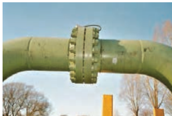
شکل ۱-۲ اتصال با فلنج
