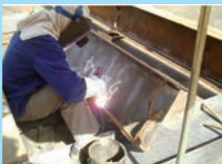
جوش طولی به روش دستی
