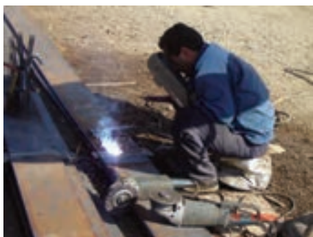
ب- جوشکاری روی درز
