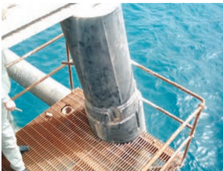
استفاده از پوشش قیری در سازه دریایی
