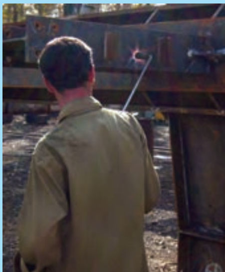
صاف کردن قطعات به کمک مارت
