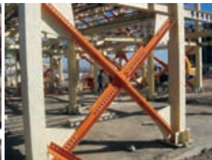
الف- مهاربندهای همگرا در اسکلت فولادی
