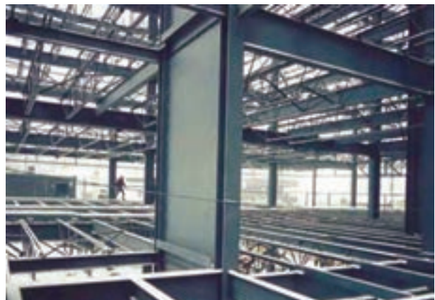
شکل ۹-۳- دیوار برشی بتنی در سازه فولادی
