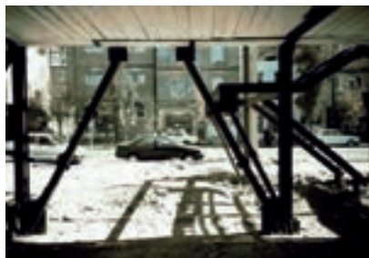
ب- مهاربند دوزنقه واگرا در اسکلت فولادی
