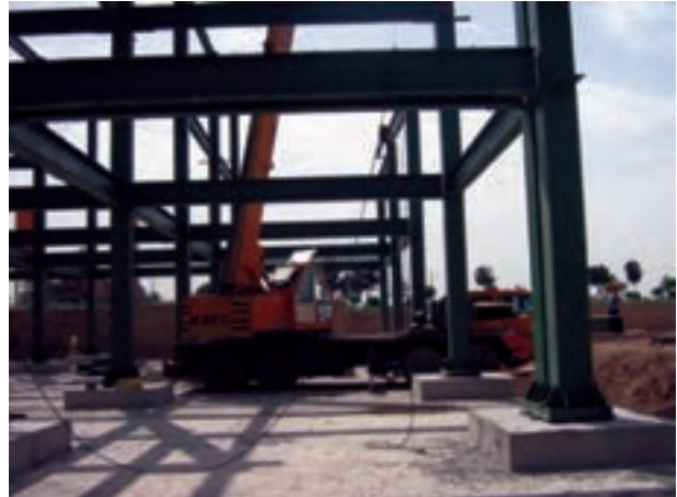
شکل ۹-۲- قاب فمشی در سازه فولادی
