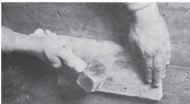
متراکم کردن با یک تخته و چکش
