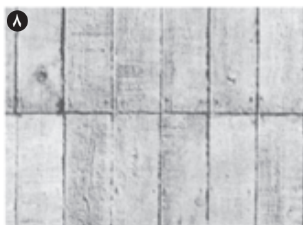
شکل ۶-۴۲- روش ترمیم دوغاب‌های اضافی که از محل درز بین دو قالب بیرون زده است.
