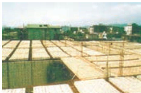
نصب صفحات سقف
