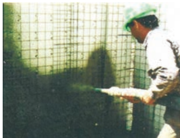
بتن پاشی روی دیوار
