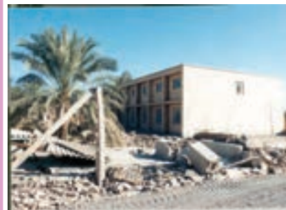
تخریب تیر برق که می تواند علاوه بر قطع برق پس از زلزله، موجب خسارت هایی از قبیل آتش سوزی و ... شود.
