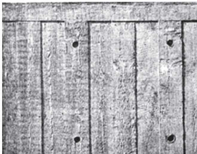
شکل ۶-۳۴- نمونه‌ای از محل‌های مهاری پر نشده
