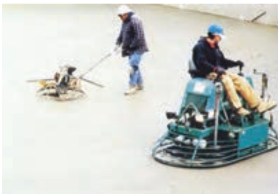
شکل ۶-۲۹- پرداخت نهایی با ابزار مکانیکی
