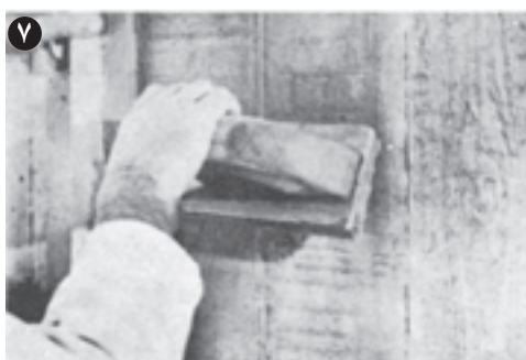
شکل ۶-۴۲- روش ترمیم دوغاب‌های اضافی که از محل درز بین دو قالب بیرون زده است.
