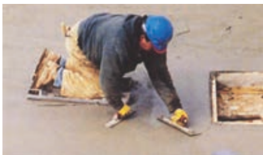
شکل ۶-۲۸- پرداخت نهایی با ابزار دستی
