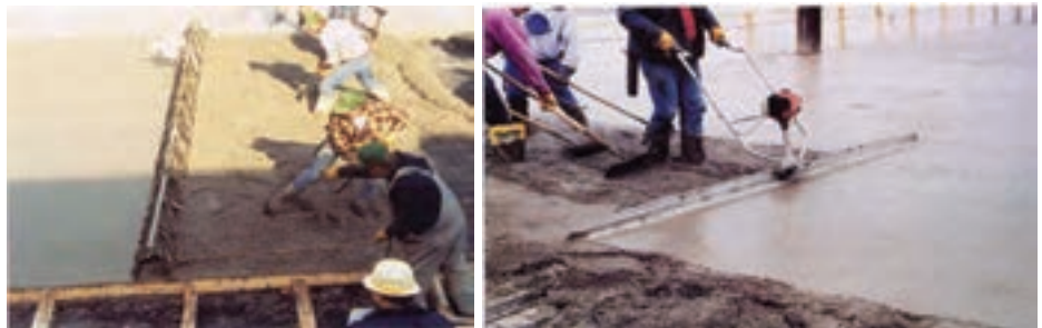
شکل ۶-۲۵- استفاده از شمشه‌های دارای ویبره برای تراز کردن و متراکم نمودن سطح، به صورت همزمان
