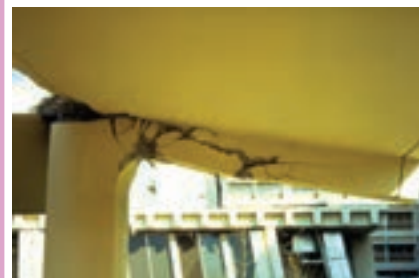
زیاد بودن طول طره و طراحی نامناسب موجب شکست تیر از محل اتصال آن شده است.
