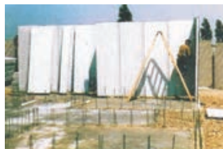
نصب صفحات بر روی فونداسیون اجرا شده
