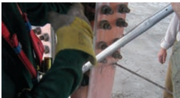
شکل ۷-۳- استفاده از پیچ‌های پرمقاومت در اتصالات
