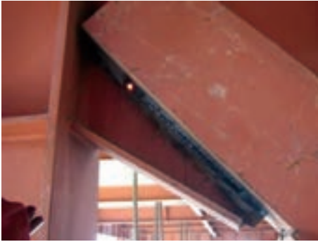
نمونه‌ای از اتصال جوشی در مهاربند سافتمان
