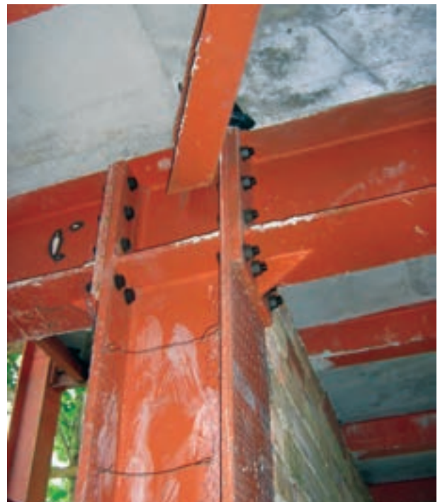
شکل ۷-۸- اتصال پیچی در ساقتمان اسکلت فولادی
