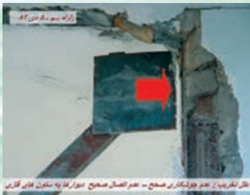
علل تخریب: عدم جوشکاری صحیح - عدم اتصال صحیح دیوارها به ستون های فلزی
