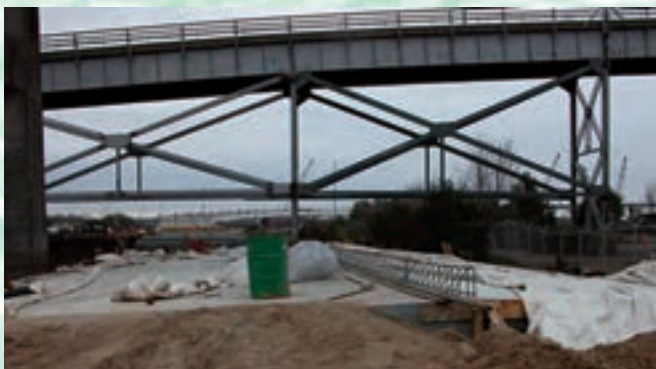
مهاربند های زیر عرشه ی پل برای مقاومت در برابر بارهای جانبی باد و زلزله
