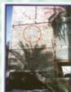
استفاده از مقاطع نامناسب در مهاربند ساختمان
