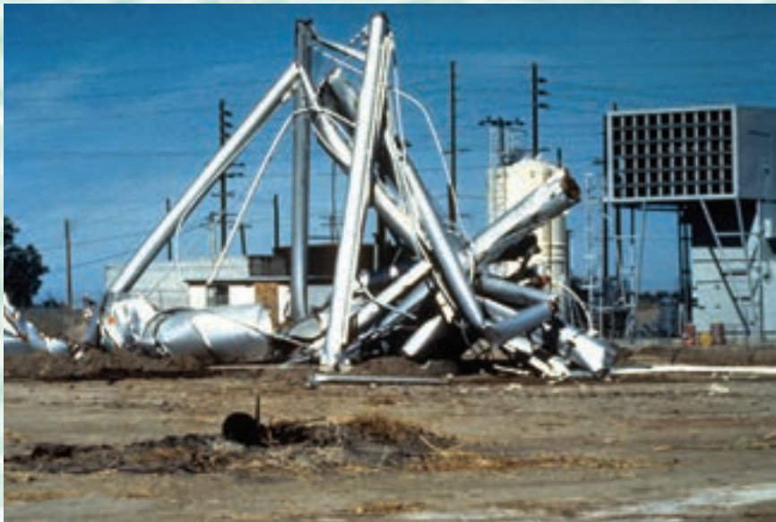
تخریب مخزن هوایی در اثر زمین لرزه به دلیل لاغری تیرها و اعضای قطری
